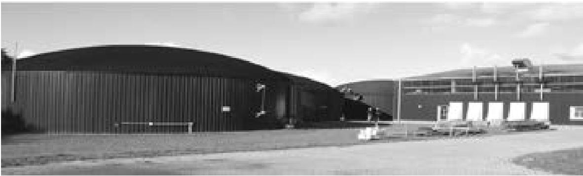
Abb. 18: Biogasanlage, bestehend aus Fermentern und baulichen Nebenanlagen
